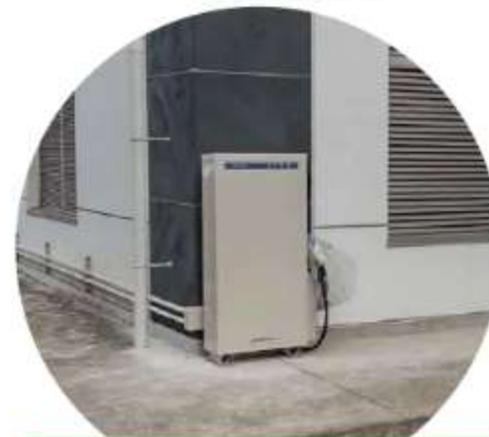
武道館には、電気自動車から建物に給電できるシステムを設置。電気自動車を「動く蓄電池」として活用できます。
