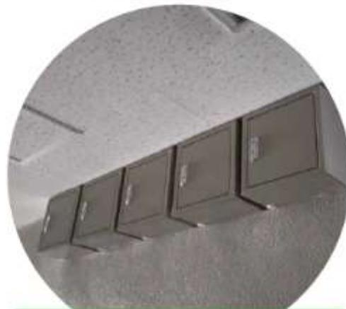
メインアリーナ入口前の廊下に設置した非常用コンセント。おひさまが出ているときであれば、停電時にこの電気を使用可能です。
