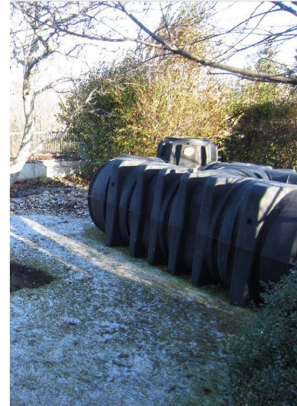
写真：土に埋められる前の雨水貯留槽
